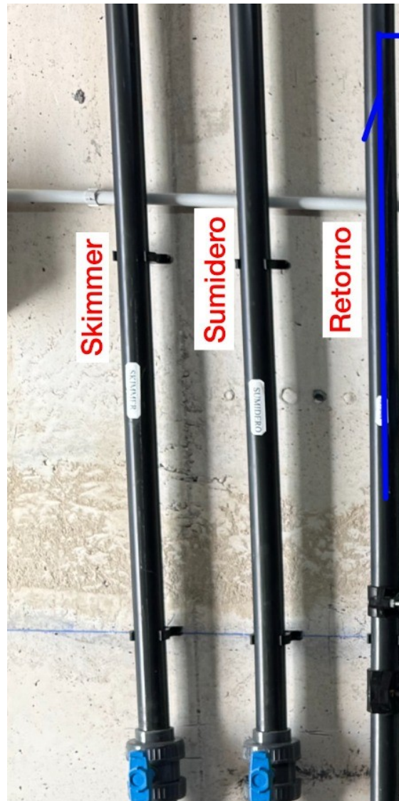
Fotografía 2. Conducciones identificadas como skimmer, sumidero y retorno.
