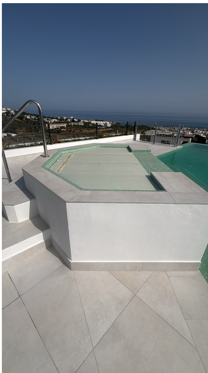
Fotografía 6. Planchas aislantes previstas para cubrir la lámina de agua durante el calentamiento y la conservación térmica.
