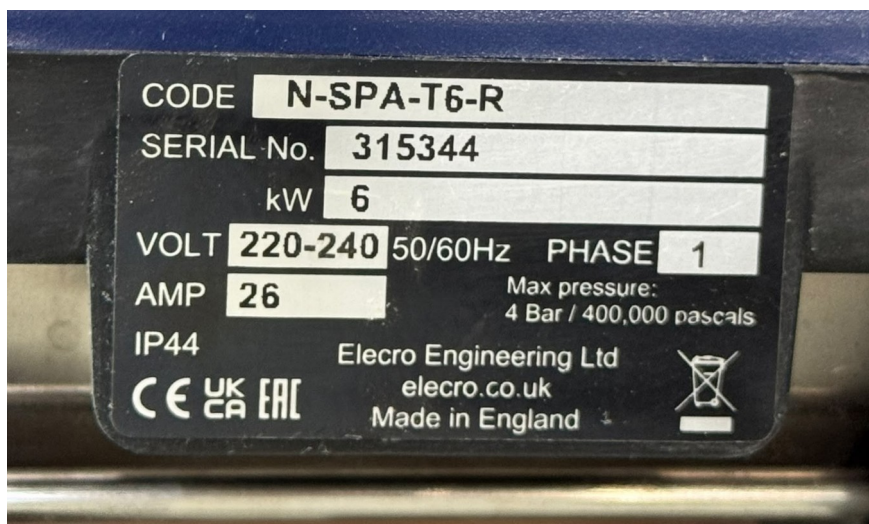
Fotografía 8. Placa de características del calentador eléctrico instalado.
