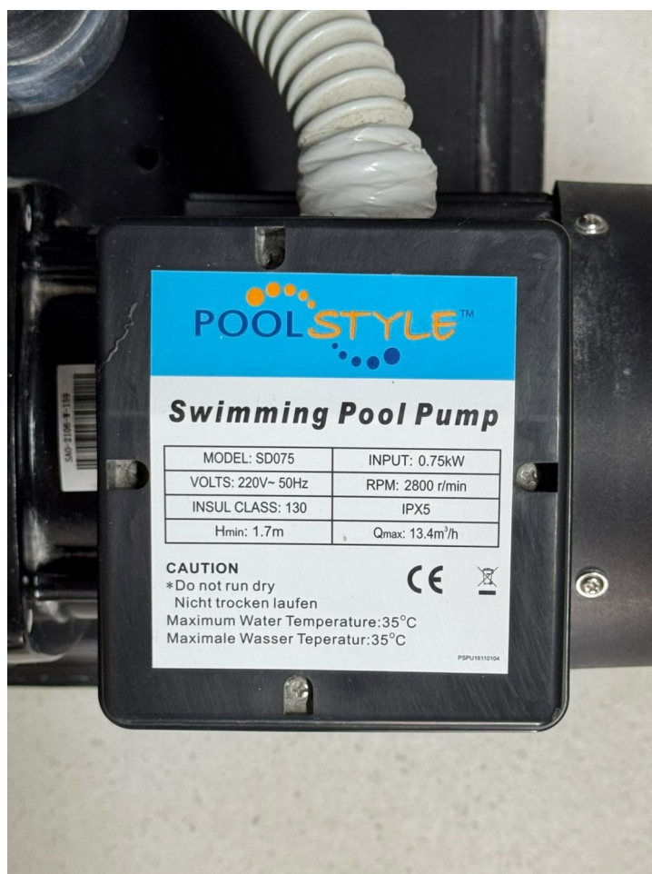
Fotografía 9. Placa de características de la bomba de recirculación PoolStyle SD075.
